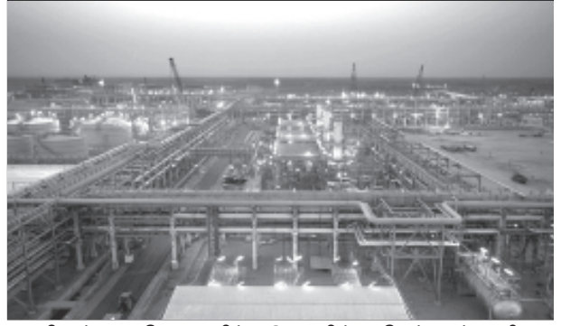
கிருஷ்ணா-கோதாவரிப் படுகையில் முகேஷ் அம்பானி அமைத்துள்ள இயற்கை எரிவாயு துரப்பணவு ஆலை: ஊரான் வீட்டு நெய்யே என் பெண்டாட்டி கையே!
